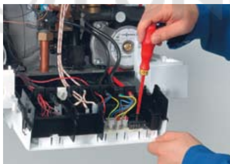
3. Подключение электрических присоединений
