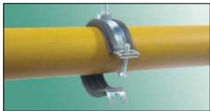
Поместить трубу в хомут
