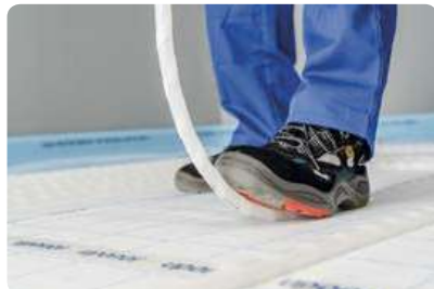
Просто прижмите трубу подошвой к поверхности панели
