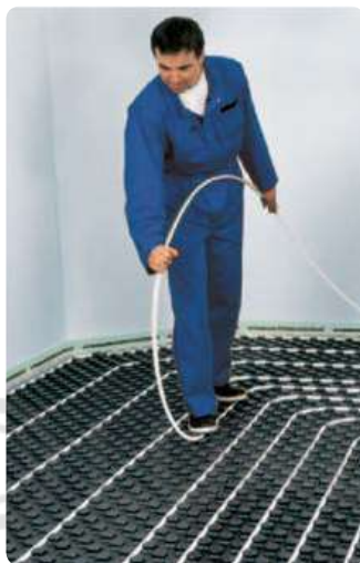
Элементы Uponor Nubos позволяют осуществлять монтаж одним человеком.
