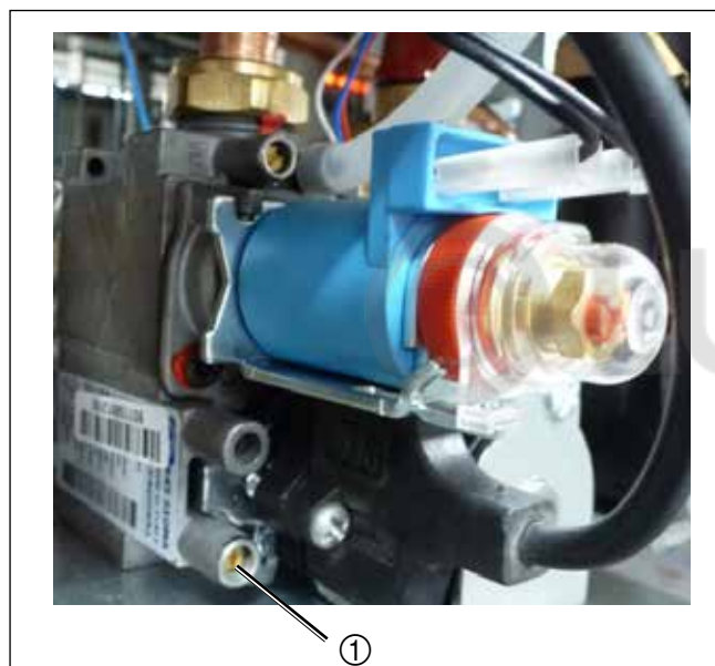
Рис. Комбинированный газовый клапан
