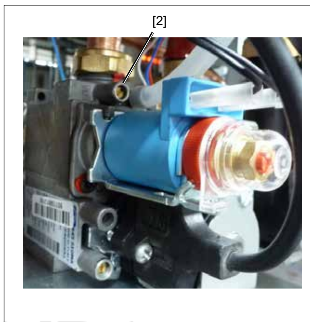
Рис. Штуцер для измерения давления в сопле
