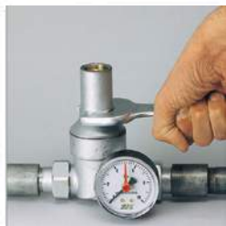
2. Отвинтите колпак, используя ключ на 32 мм.
