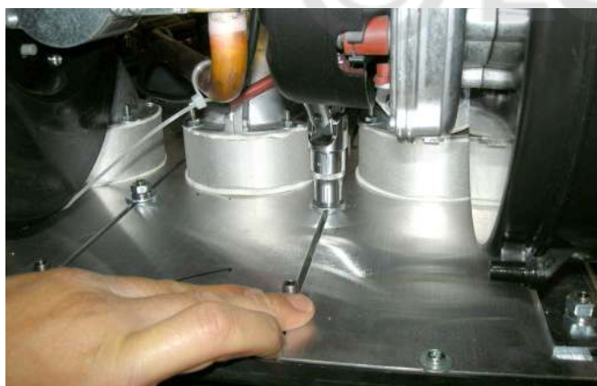
- Вынуть винты "А" для каждого элемента (с помощью торцевого ключа 13 мм).
