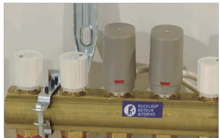
Рисунок 9. Электротермические сервоприводы, установленные на коллектор.
