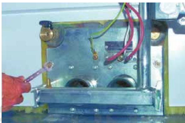
рис. 22 - Демонтаж горелок
