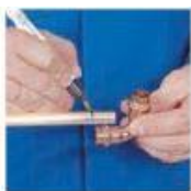
Отметить, на какую глубину труба должна войти в фитинг.
