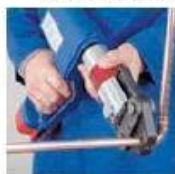
После того как Вы удостоверились, что труба не сдвинулась, начните опрессовку. После окончания полного цикла зажима раздвиньте обжимные губки и снимите их с фитинга.
