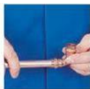
Оборотным движением надвинуть фитинг на трубу до упора.
