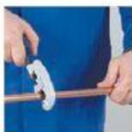
Обрезать трубу под прямым углом с помощью трубореза.
