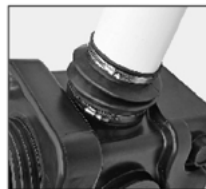
Рис. 9 Монтаж вентиляционного трубопровода
