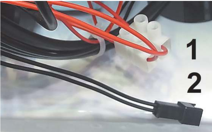
Рис. 7. Доступ к соединительным колодкам подключения комнатного термостата (1) и датчика температуры бойлера (2)
