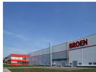
Производственный комплекс BROEN в Коломне
