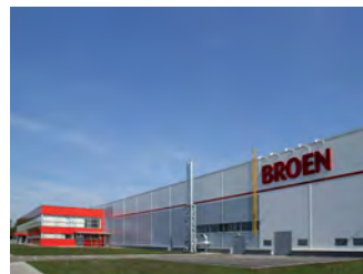
Производственный комплекс BROEN в Коломне
