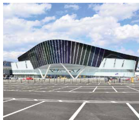
Конгресс-Холл, Екатеринбург-ЭКСПО, г. Екатеринбург
