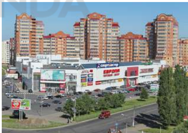
ТОРГОВЫЙ ЦЕНТР «ЕВРОПА 26» Железногорск, 320 кВт
