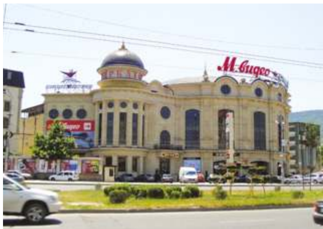
ТОРГОВЫЙ ЦЕНТР «МИРКАТО» Махачкала, 590 кВт
