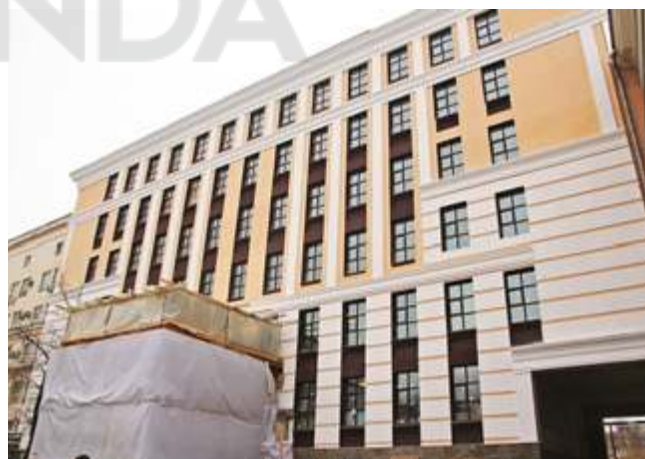
БИЗНЕС-ЦЕНТР «БАСМАНЫЙ ПАРК» Москва, 495 кВт
