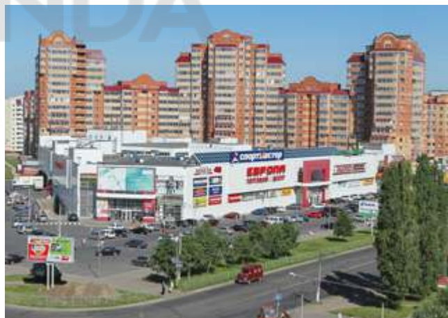
ТОРГОВЫЙ ЦЕНТР «ЕВРОПА 26» Железногорск, 320 кВт
