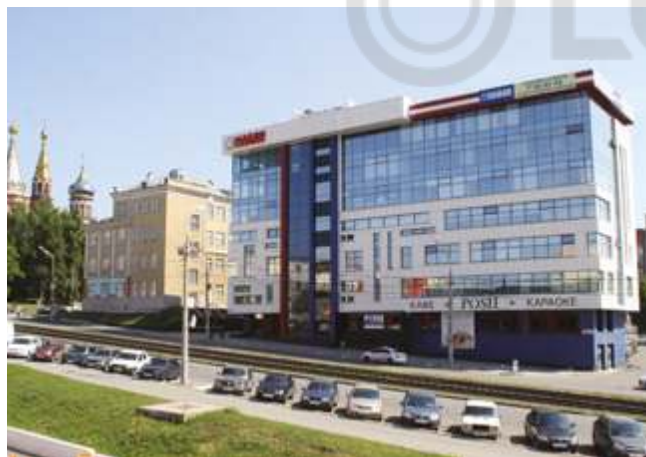
БИЗНЕС-ЦЕНТР «НАЙДИ» Ижевск, 498 кВт
