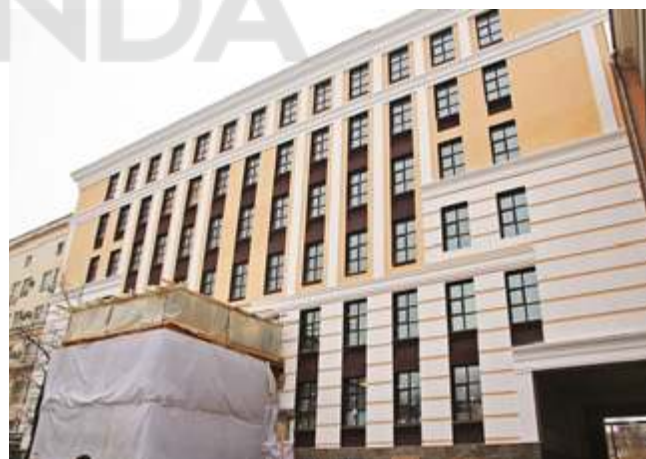
БИЗНЕС-ЦЕНТР «БАСМАНЫЙ ПАРК» Москва, 495 кВт
