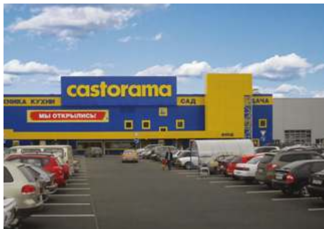
ГИПЕРМАРКЕТ СТРОИТЕЛЬНЫХ ТОВАРОВ «КАСТОРАМА» Уфа, 1 МВт
