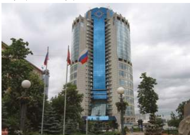
ГУП «МОСВОДОСТОК» Москва, 440 кВт
