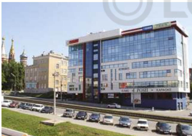
БИЗНЕС-ЦЕНТР «НАЙДИ» Ижевск, 498 кВт
