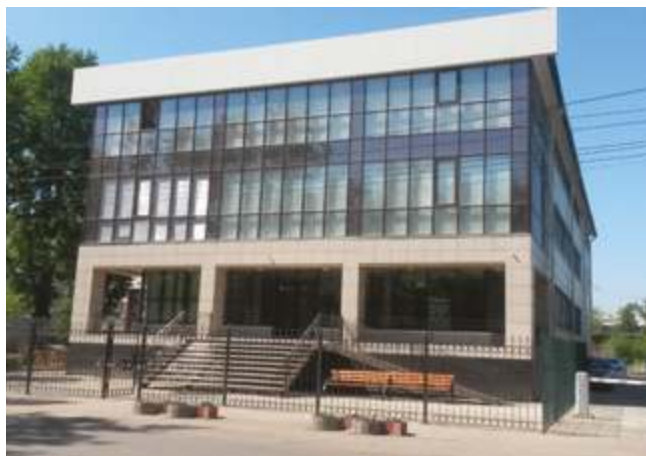
КОЛ-ЦЕНТР «ТЕЛЕ2» Иркутск, 300 кВт
