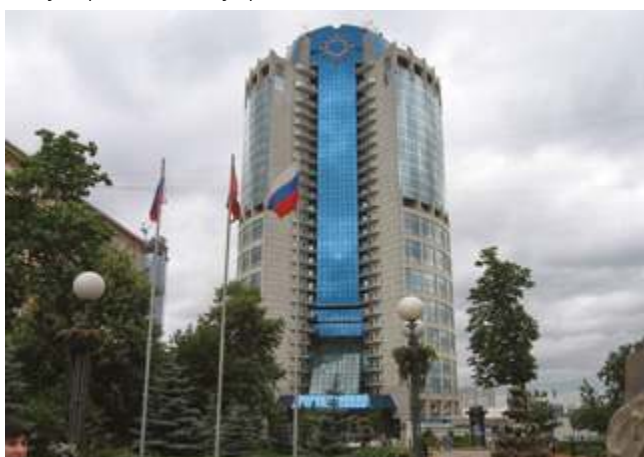
ГУП «МОСВОДОСТОК» Москва, 440 кВт
