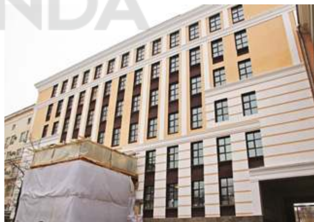
БИЗНЕС-ЦЕНТР «БАСМАНЫЙ ПАРК» Москва, 495 кВт
