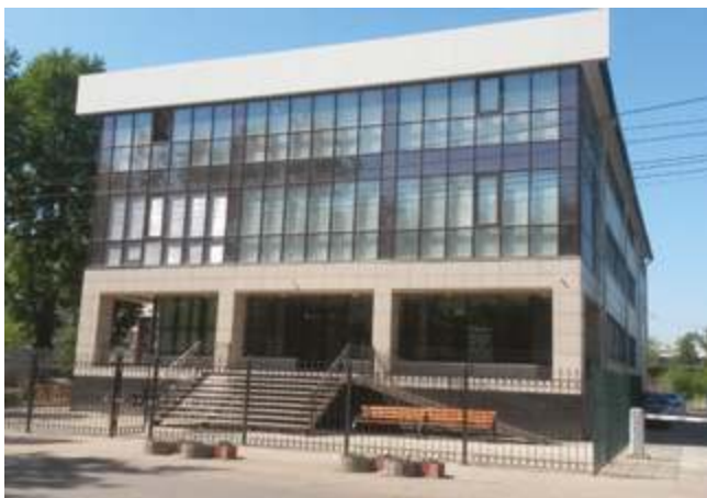
КОЛ-ЦЕНТР «ТЕЛЕ2» Иркутск, 300 кВт
