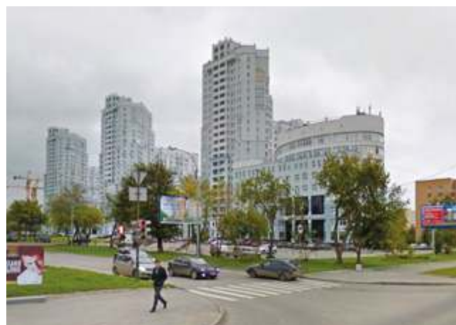
БИЗНЕС-ЦЕНТР «ТАТИЩЕВСКИЙ» Екатеринбург, 500 кВт
