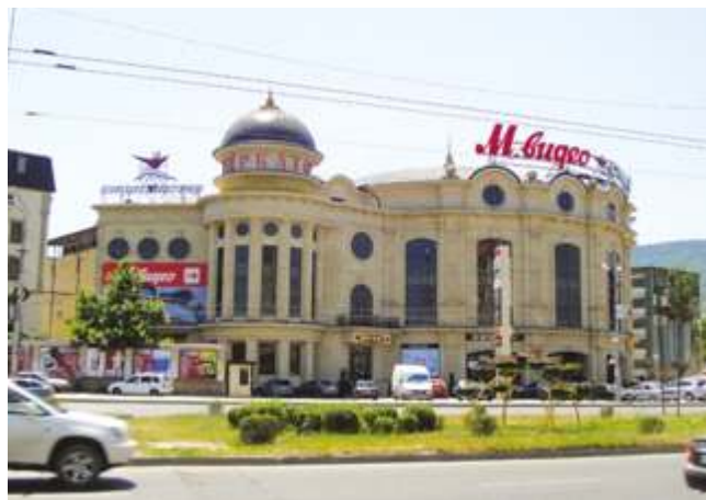
ТОРГОВЫЙ ЦЕНТР «МИРКАТО» Махачкала, 590 кВт
