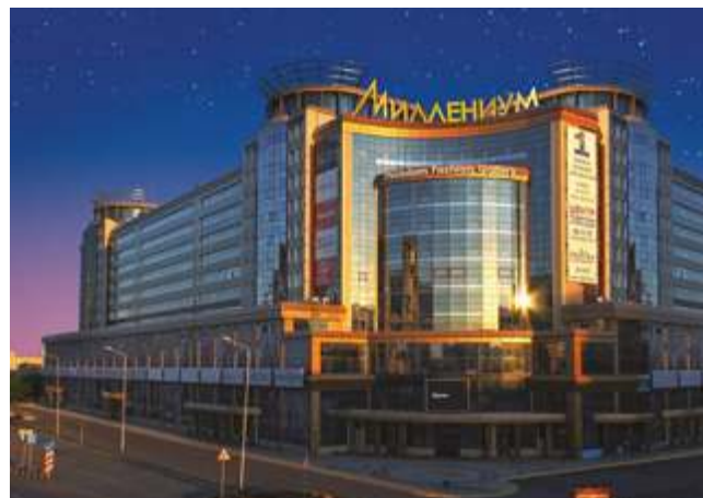
ТОРГОВЫЙ ЦЕНТР «МИЛЛЕНИУМ» Омск, 410 кВт
