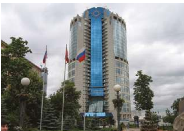
ГУП «МОСВОДОСТОК» Москва, 440 кВт
