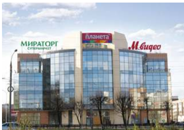
ТОРГОВЫЙ ЦЕНТР «ПЛАНЕТА» Йошкар-Ола, 836 кВт
