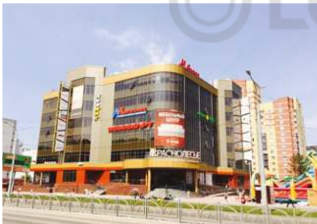
ТОРГОВЫЙ ЦЕНТР «КРАСНОЛЕСЬЕ» Екатеринбург, 700 кВт
