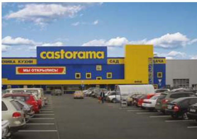
ГИПЕРМАРКЕТ СТРОИТЕЛЬНЫХ ТОВАРОВ «КАСТОРАМА» Уфа, 1 МВт
