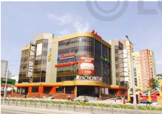
ТОРГОВЫЙ ЦЕНТР «КРАСНОЛЕСЬЕ» Екатеринбург, 700 кВт
