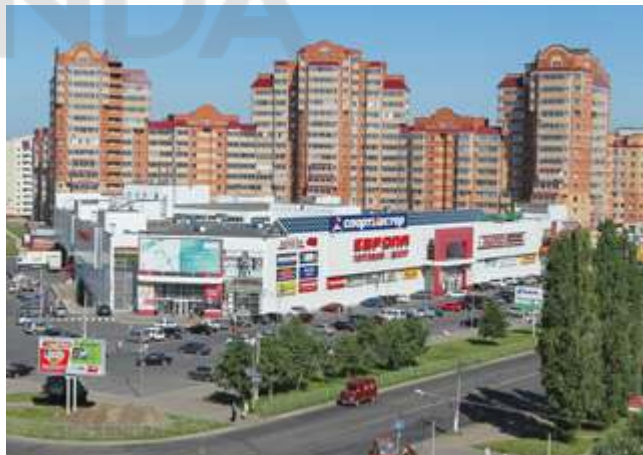
ТОРГОВЫЙ ЦЕНТР «ЕВРОПА 26» Железногорск, 320 кВт
