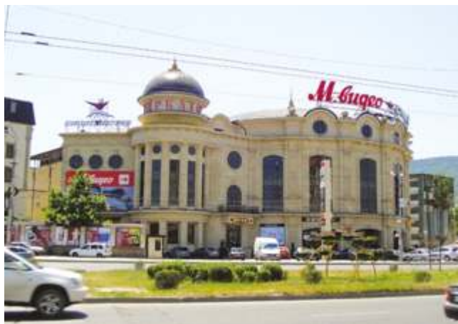
ТОРГОВЫЙ ЦЕНТР «МИРКАТО» Махачкала, 590 кВт
