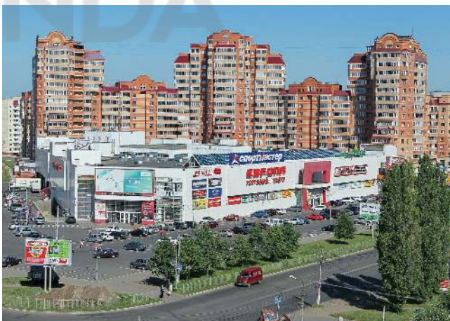
ТОРГОВЫЙ ЦЕНТР «ЕВРОПА 26» Железногорск, 320 кВт
