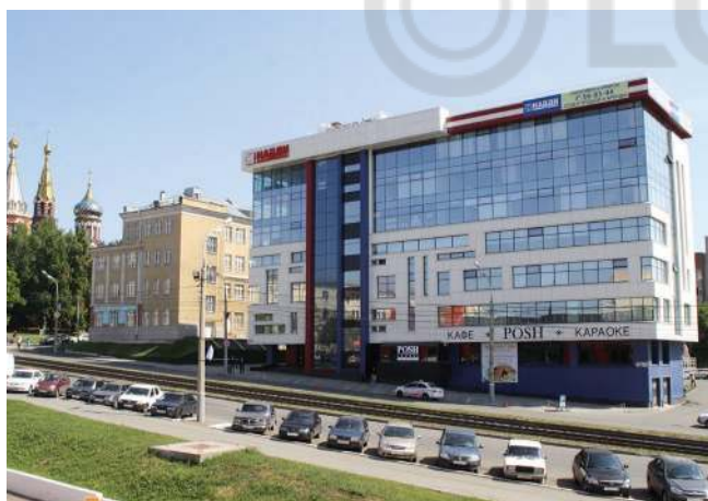
БИЗНЕС-ЦЕНТР «НАЙДИ» Ижевск, 498 кВт
