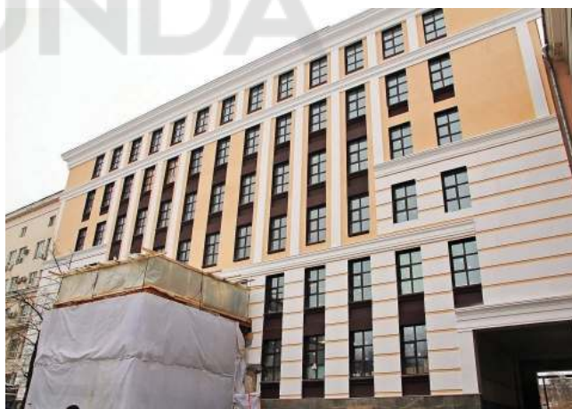
БИЗНЕС-ЦЕНТР «БАСМАНЫЙ ПАРК» Москва, 495 кВт
