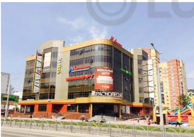
ТОРГОВЫЙ ЦЕНТР «КРАСНОЛЕСЬЕ» Екатеринбург, 700 кВт
