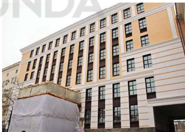
БИЗНЕС-ЦЕНТР «БАСМАНЫЙ ПАРК» Москва, 495 кВт
