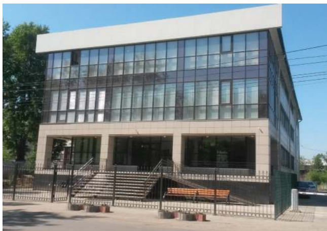
КОЛЛ-ЦЕНТР «ТЕЛЕ2» Иркутск, 300 кВт
