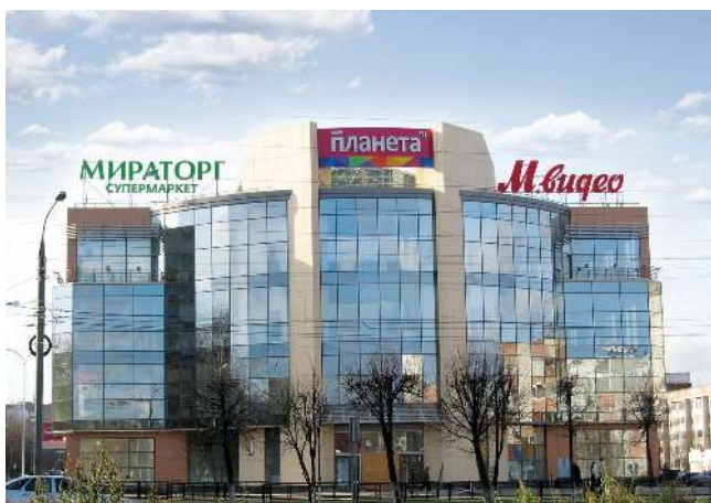
ТОРГОВЫЙ ЦЕНТР «ПЛАНЕТА» Йошкар-Ола, 836 квТ
