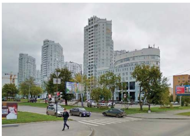
БИЗНЕС-ЦЕНТР «ТАТИЩЕВСКИЙ» Екатеринбург, 500 кВт
