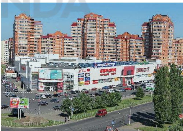
ТОРГОВЫЙ ЦЕНТР «ЕВРОПА 26» Железногорск, 320 кВт
