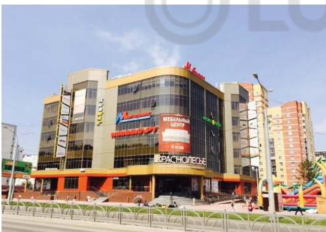
ТОРГОВЫЙ ЦЕНТР «КРАСНОЛЕСЬЕ» Екатеринбург, 700 кВт
