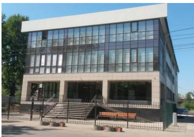
КОЛЛ-ЦЕНТР «ТЕЛЕ2» Иркутск, 300 кВт
