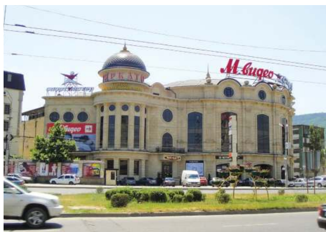
ТОРГОВЫЙ ЦЕНТР «МИРКАТО» Махачкала, 590 кВт
