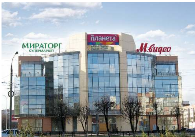
ТОРГОВЫЙ ЦЕНТР «ПЛАНЕТА» Йошкар-Ола, 836 квТ
