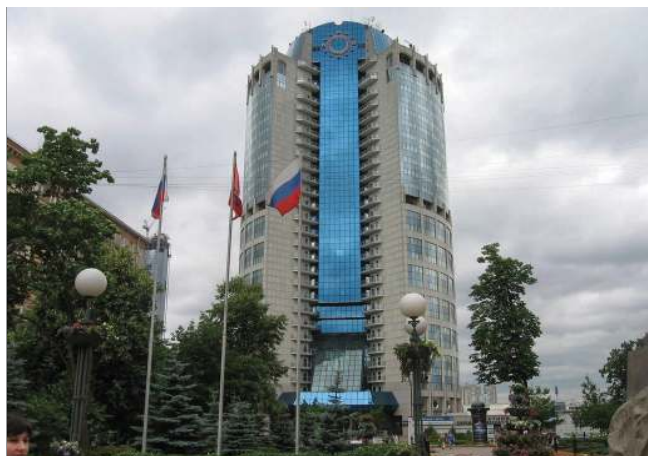
ГУП «МОСВОДОСТОК» Москва, 440 кВт
