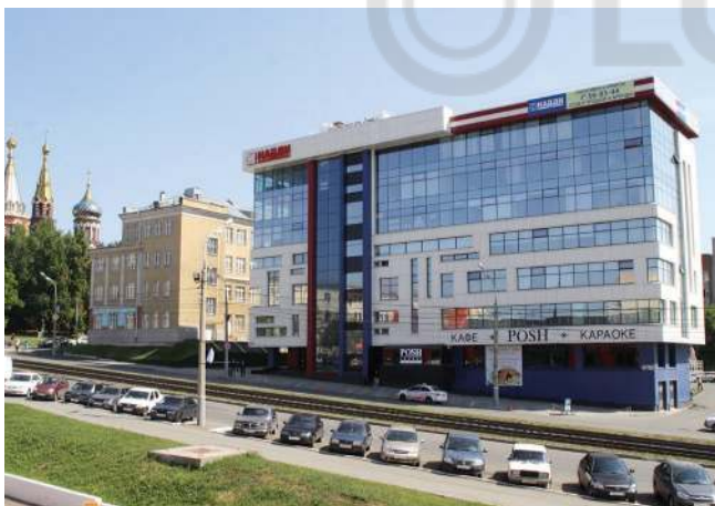
БИЗНЕС-ЦЕНТР «НАЙДИ» Ижевск, 498 кВт
