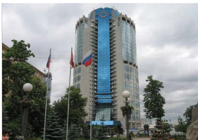
ГУП «МОСВОДОСТОК» Москва, 440 кВт
