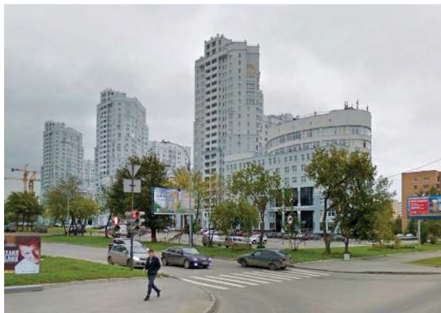
БИЗНЕС-ЦЕНТР «ТАТИЩЕВСКИЙ» Екатеринбург, 500 кВт
