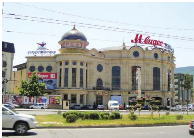
ТОРГОВЫЙ ЦЕНТР «МИРКАТО» Махачкала, 590 кВт
