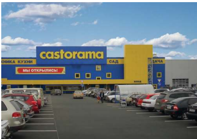
ГИПЕРМАРКЕТ СТРОИТЕЛЬНЫХ ТОВАРОВ «КАСТОРАМА» Уфа, 1 МВт
