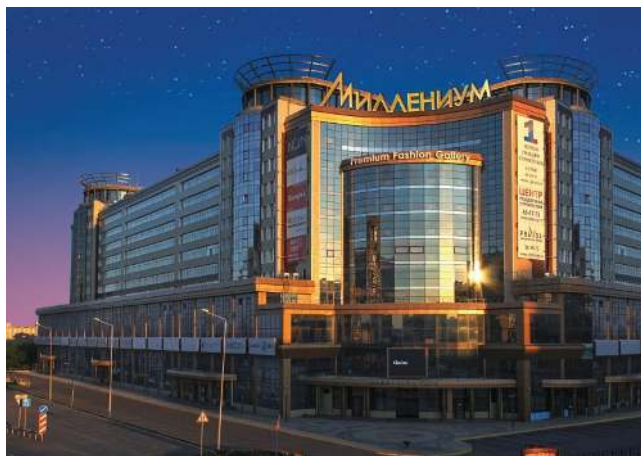
ТОРГОВЫЙ ЦЕНТР «МИЛЛЕНИУМ» Омск, 410 кВт
