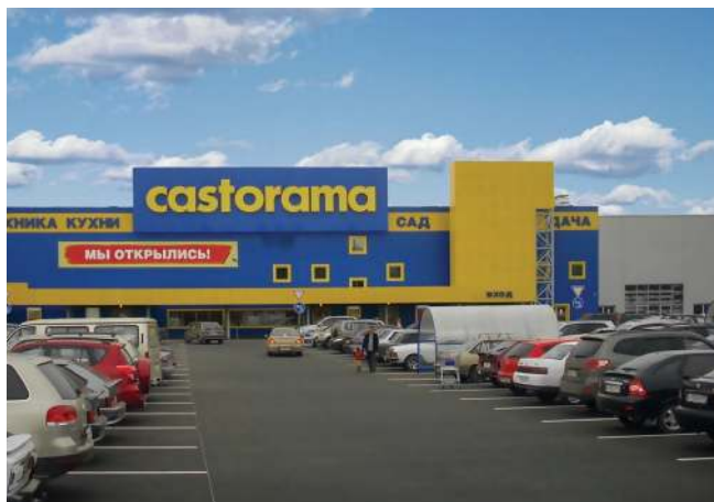
ГИПЕРМАРКЕТ СТРОИТЕЛЬНЫХ ТОВАРОВ «КАСТОРАМА» Уфа, 1 МВт
