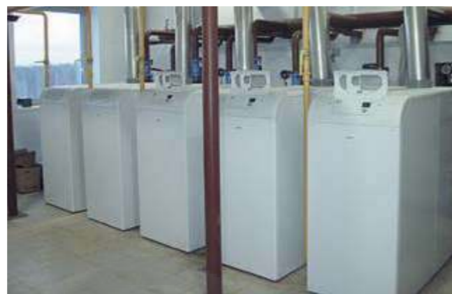
Кинотеатр, г. Йошка-Ола Общая мощность - 1,6 МВт
