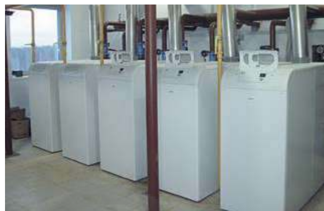
Кинотеатр, г. Йошка-Ола Общая мощность - 1,6 МВт
