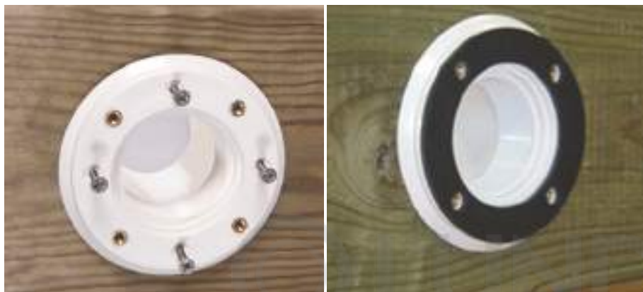
Рисунок 24 – Монтаж корпуса возвратной форсунки и уплотнения
