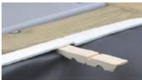
Рисунок 32 – Фиксация лайнера с помощью половинки прищепки
