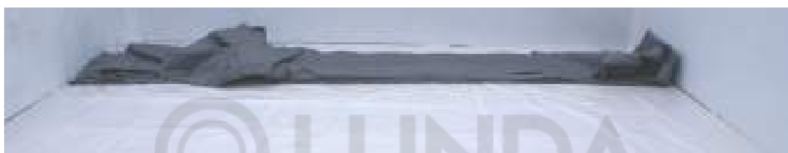
Рисунок 33 – Разворачивание лайнера
