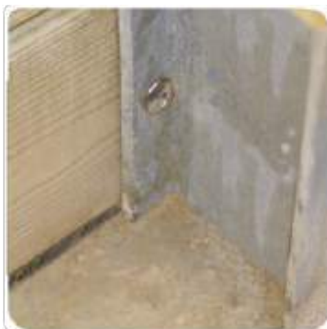
Рисунок 11 – Фиксация досок с проемами на опорных стойках
