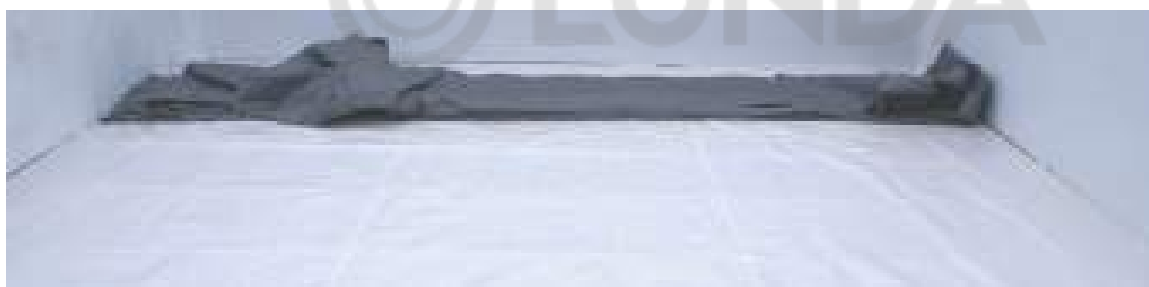
Figure 32 – Разворачивание лайнера
