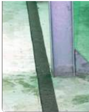
Figure 8 – Установка битумных полос
