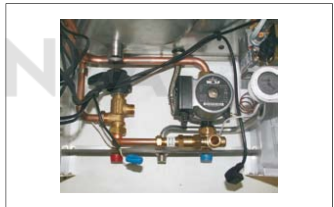
Рис.: Блок подключения демонтирован
