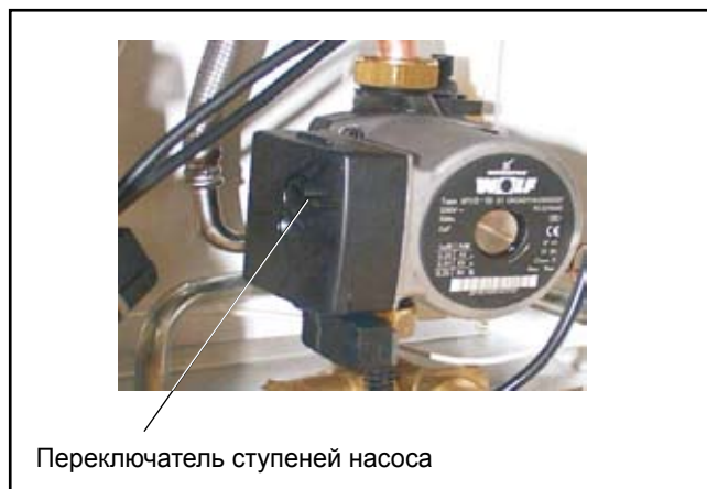
Рис: Переключатель ступеней на насосе котлового контура
