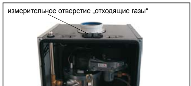
Рис.: Измерение отходящих газов на открытом котле
