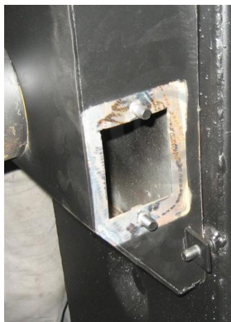
Рис. 10. Отверстие для чистки адаптера дымохода.
