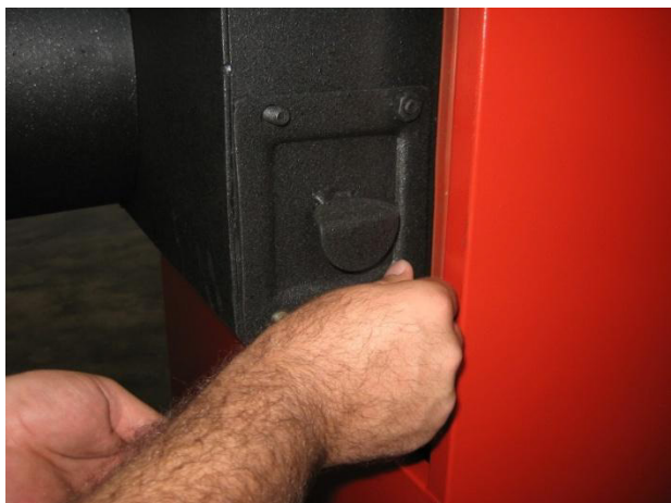
Рис. 9. Снятие заглушки для чистки адаптера дымохода.
