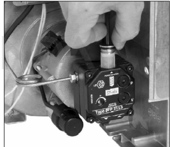
Рисунок 29 – Демонтаж топливного фильтра
