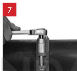
Завершение сборки жесткой муфты
