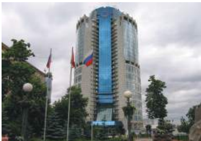
ГУП «МОСВОДОСТОК» Москва, 440 кВт
