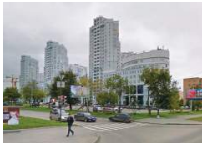
БИЗНЕС-ЦЕНТР «ТАТИЩЕВСКИЙ» Екатеринбург, 500 кВт
