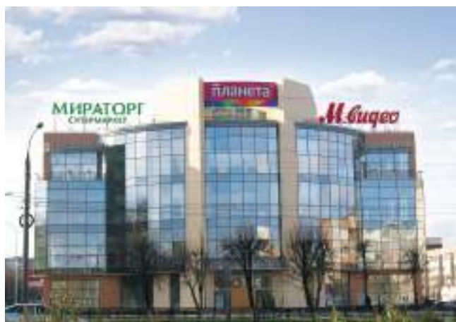
ТОРГОВЫЙ ЦЕНТР «ПЛАНЕТА» Йошкар-Ола, 836 кВт
