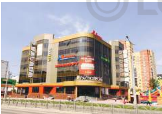
ТОРГОВЫЙ ЦЕНТР «КРАСНОЛЕСЬЕ» Екатеринбург, 700 квт
