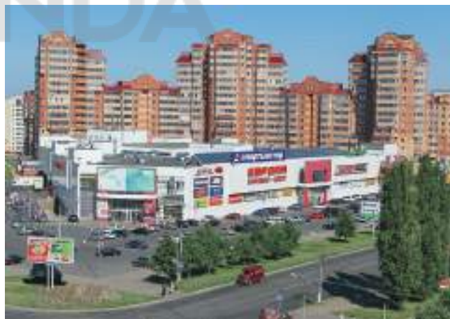
ТОРГОВЫЙ ЦЕНТР «ЕВРОПА 26» Железногорск, 320 квт
