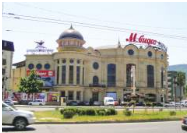
ТОРГОВЫЙ ЦЕНТР «МИРКАТО» Махачкала, 590 кВт
