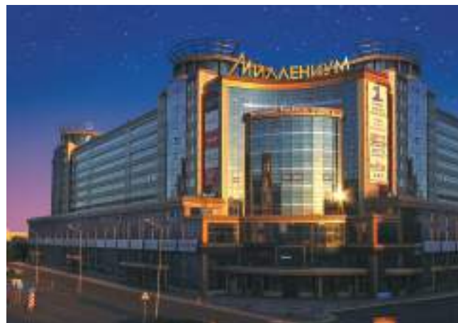
ТОРГОВЫЙ ЦЕНТР «МИЛЛЕНИУМ» Омск, 410 кВт
