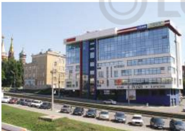
БИЗНЕС-ЦЕНТР «НАЙДИ» Ижевск, 498 кВт
