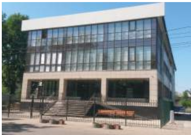
КОЛ-ЦЕНТР «ТЕЛЕ2» Иркутск, 300 кВт
