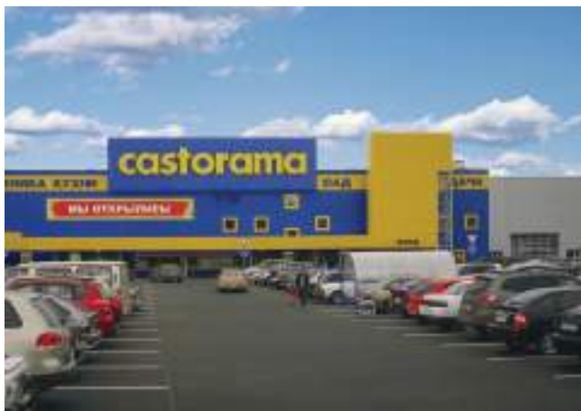
ГИПЕРМАРКЕТ СТРОИТЕЛЬНЫХ ТОВАРОВ «КАСТОРАМА» Уфа, 1 МВт
