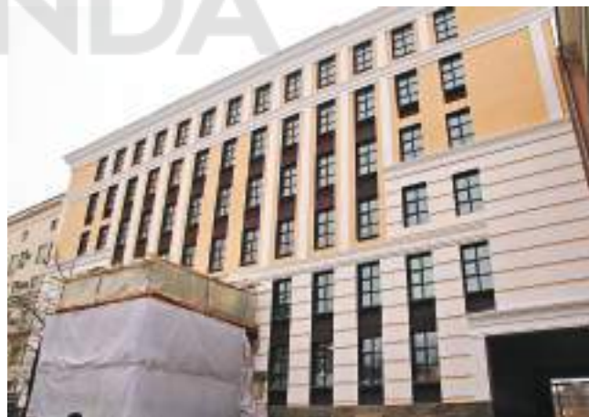
БИЗНЕС-ЦЕНТР «БАСМАНЫЙ ПАРК» Москва, 495 кВт
