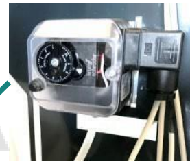
Ограничитель давления дымовых газов 9 мбар
