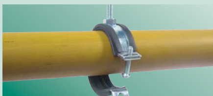
Поместить трубу в хомут
