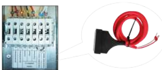
Рис. 20 Подключение трёхходового клапана к клеммной колодке
