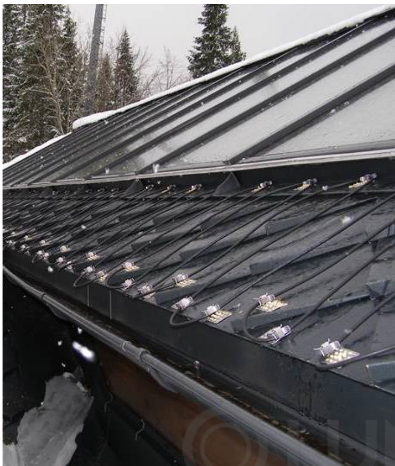
Край металлической кровли с подвесным жёлобом.
