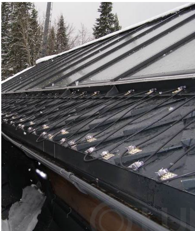
Край металлической кровли с подвесным жёлобом.
