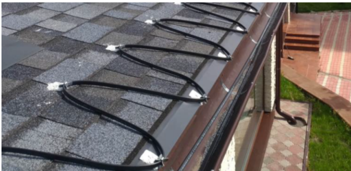
Проблемный участок крыши. Кровля - катепал.
